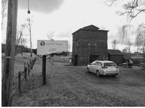
第6図 Hagelsrum 製鉄所高炉全景
